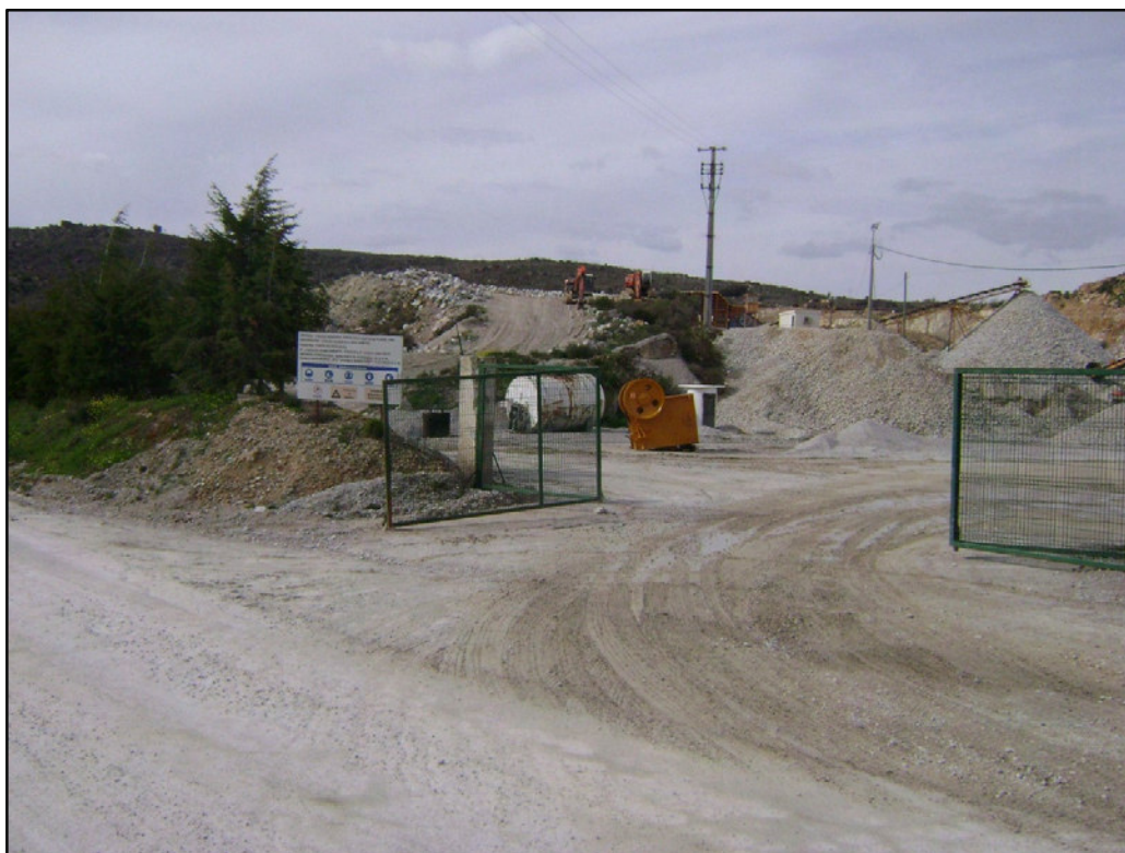
Fotografia n.º 5 – Sinalização à entrada da pedreira
